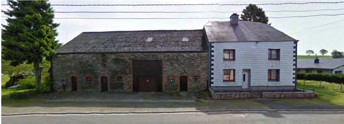
Source : Google Street View – Juseret 46 avant les travaux de la phase 1.
