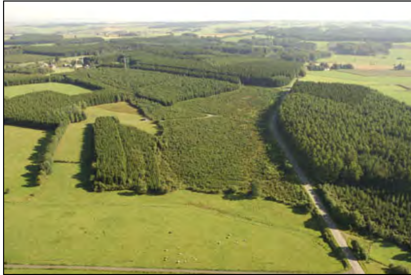
Annexe n° 6.4 : Le Parc d'Activités Economiques de Nives avant les travaux du data center
