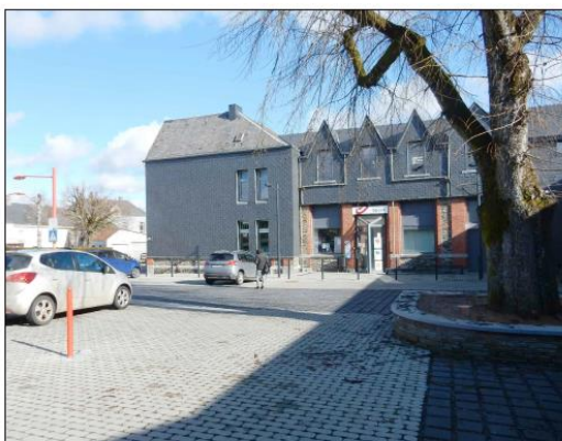
Photo 3 - depuis la place - façade latérale droite
